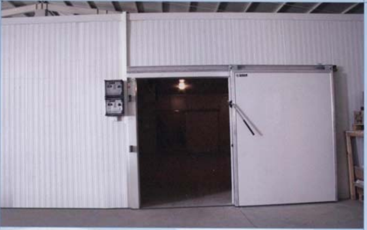
1 Soğuk Hava Deposu Dış Görünüm
