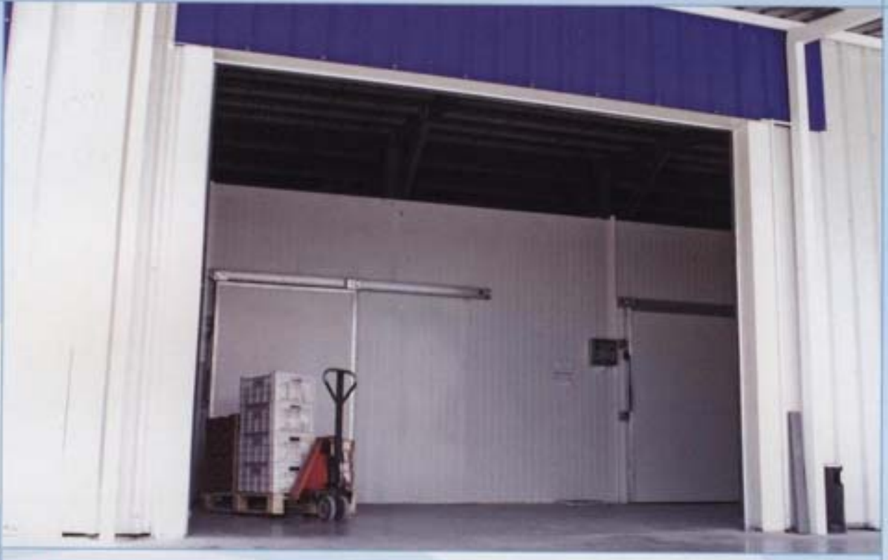
13 Soğuk Hava Deposu Dış Görünüm
