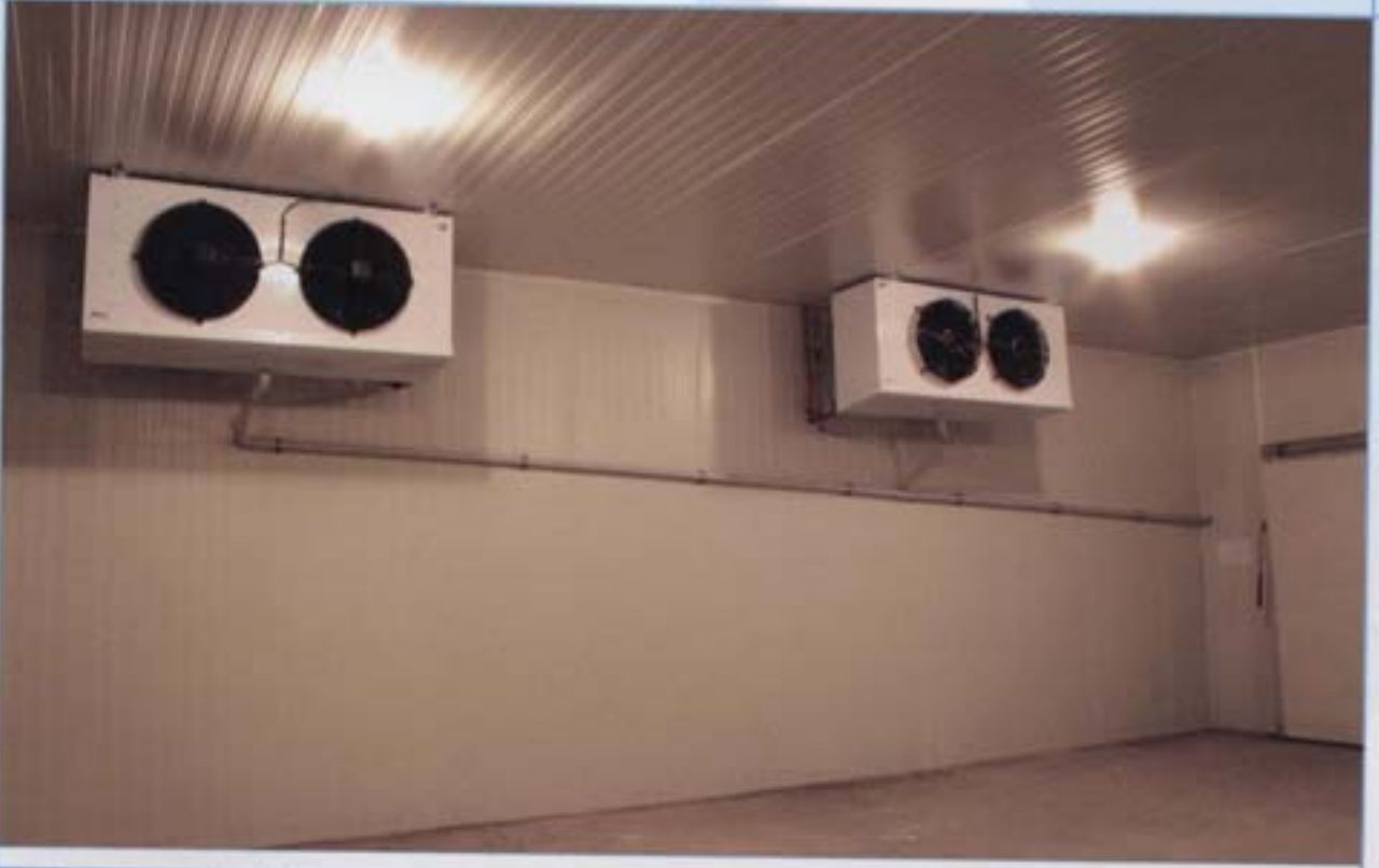
4 Multi İç Ünite Montaj Şekli
