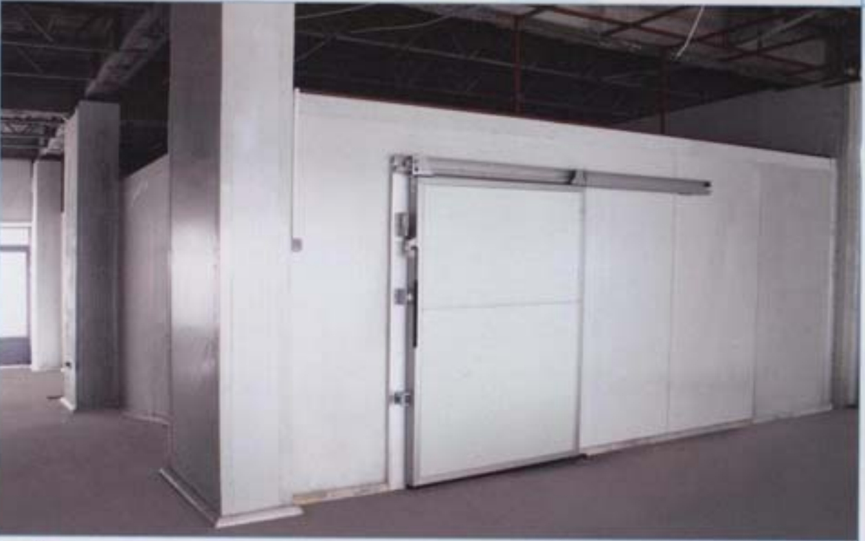
14 Soğuk Hava Deposu Dış Görünüm
